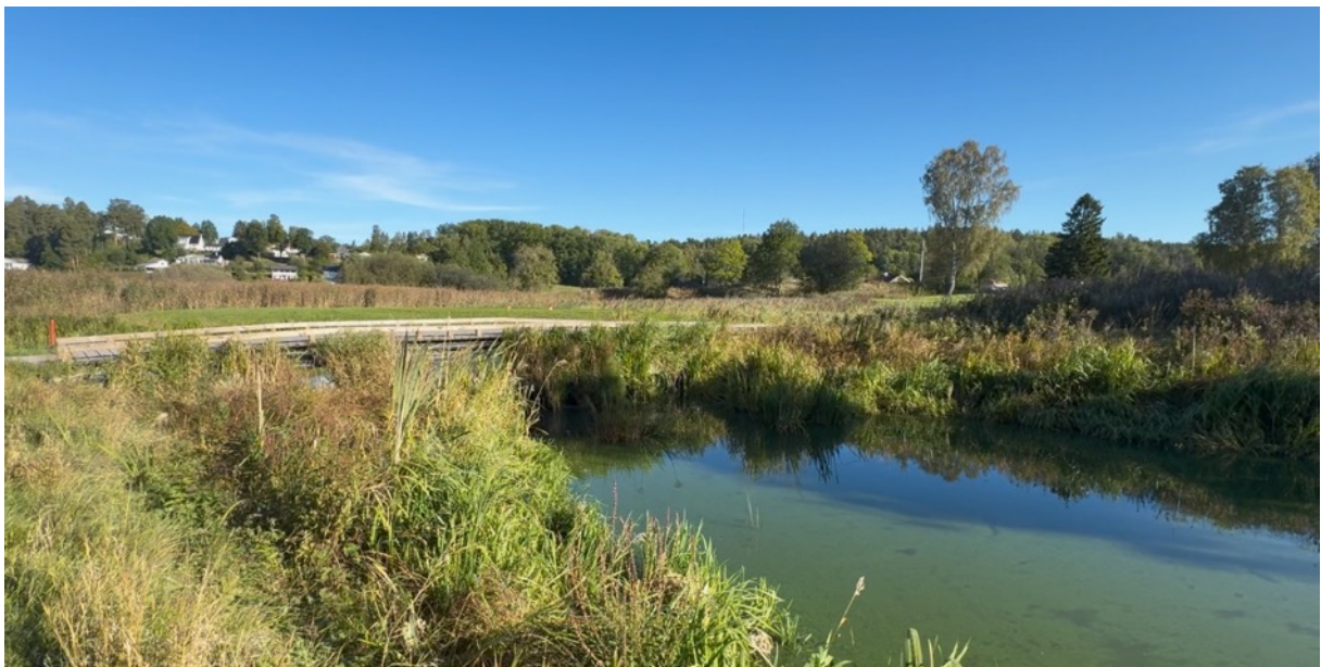
Ovan: Asplångens utlopp med felkonstruerad öppning – underdimensionerad och med felaktig profil. Vattnet fyller en damm på golfbanan (inte bevattningsdammen) och överskottet rinner vidare i stora Lillån.
